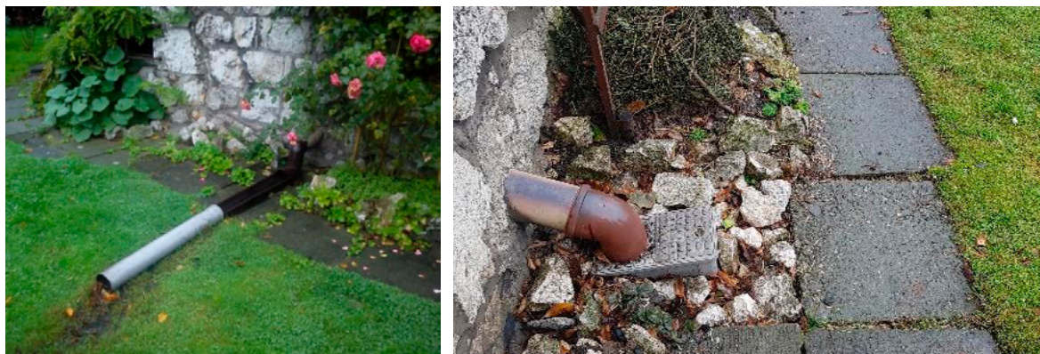
Odprowadzenie wody z rynny na trawnik. Docelowo to tymczasowe rozwiązanie zastąpiono drenażem rozsączającym przedłużając rurę (perforowaną) pod ziemię do około 8 m w kierunku ogrodu – fotografia po prawej stronie (fot. M. Siudak)
