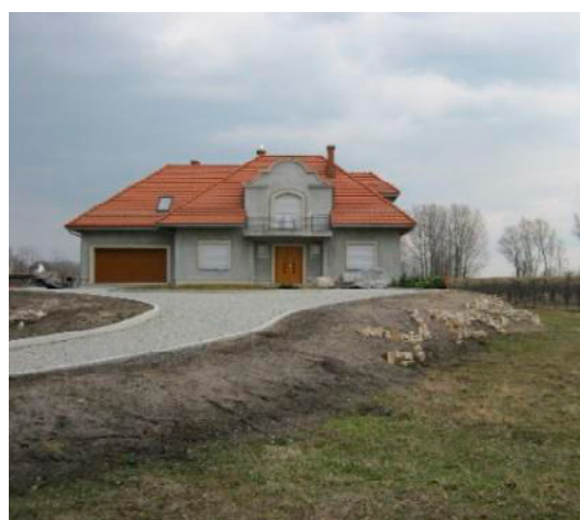
Dom na nasypie, zawale Wisły w okolicach Osieka (fot. R. Konieczny)
