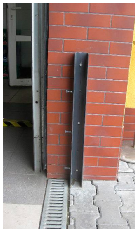
Sposób przechowywania i zakładania tymczasowej osłony na wjazd do warsztatu (fot. M. Siudak)
