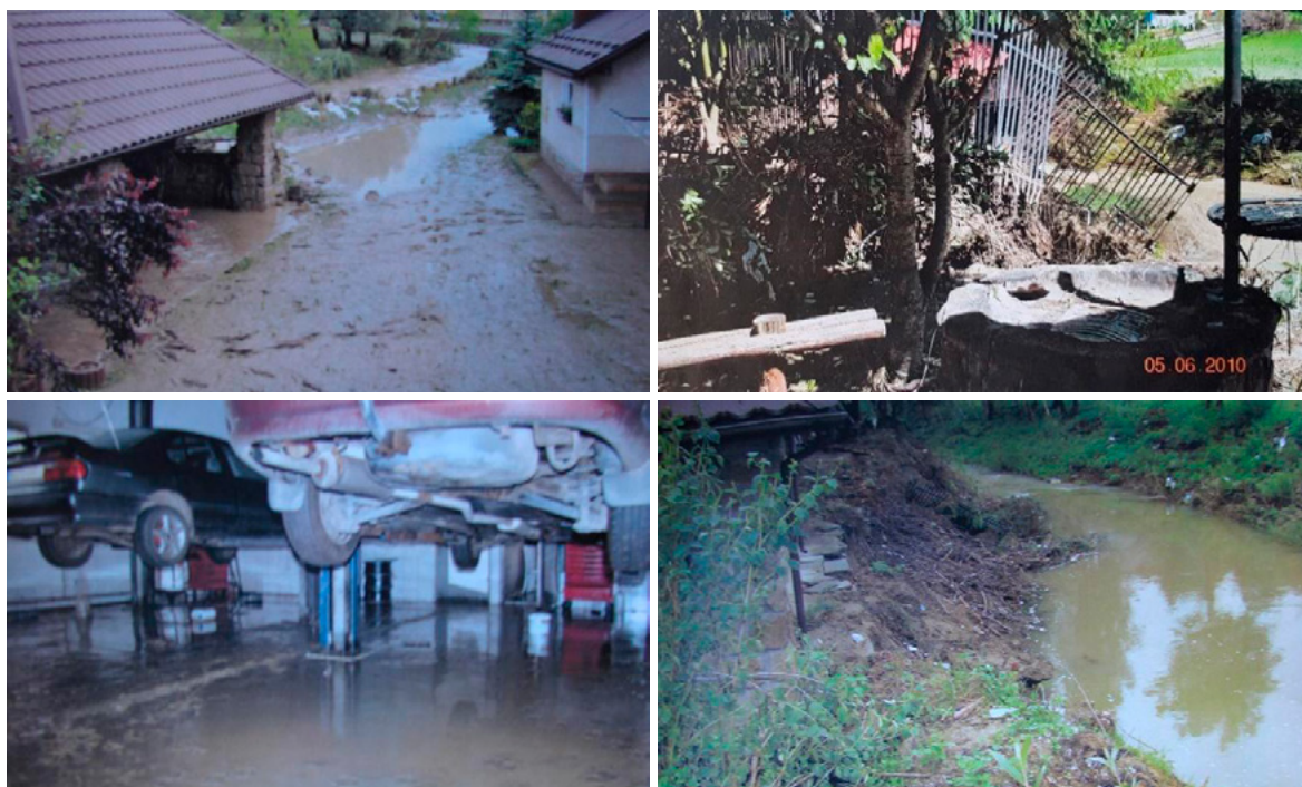
Szkody wyrządzone przez powódź w 2010 roku w gospodarstwie. Na górze po lewej stronie rzeka i dom z wyraźnie widocznym śladem poziomu wody. Na dole po lewej uratowane na podnośnikach samochody klientów.
