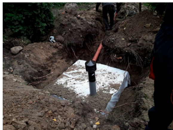
Skrzynka rozsączająca podłączona do spustu z rynny (fot. B. Grzebulska Fundacja Psubraty)
