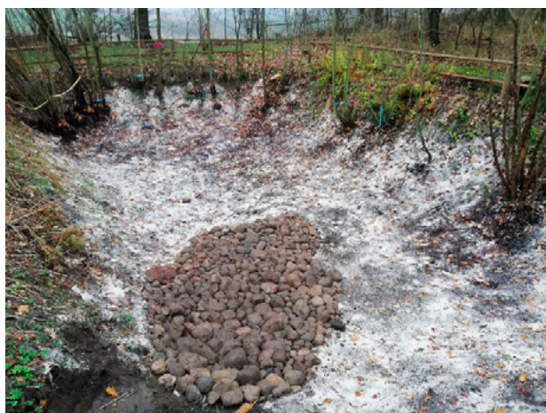
Niecka infiltracyjna („oczko wodne”) do gromadzenia wód opadowych (fot. B. Grzebułska Fundacja Psułaty)
