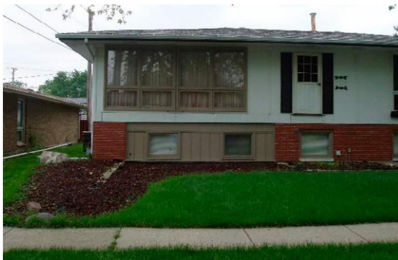
USA, okolice Chicago. Zlikwidowany garaż podziemny na terenach, gdzie występują częste powodzie, choć woda nie jest głęboka (fot. R. Konieczny)
