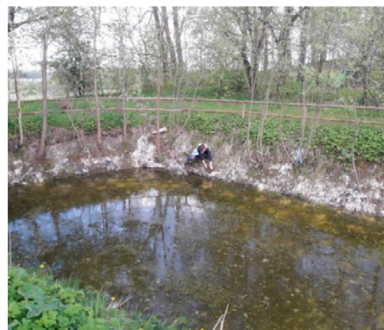
Niecka infiltracyjna („oczko wodne”) do gromadzenia wód opadowych (fot. B. Grzebułska Fundacja Psułaty)
