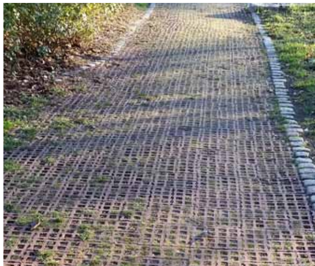
Półprzepuszczalne ścieżki w parkach
