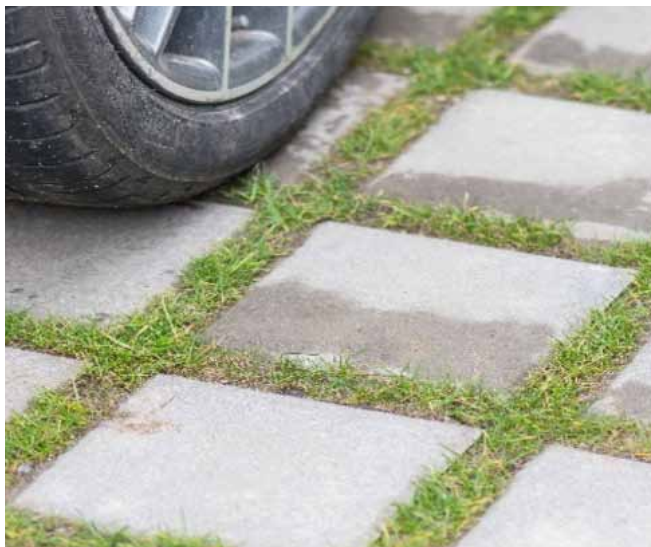
Przepuszczalne powierzchnie na parkingach i drogach osiedlowych retencjonują wodę
