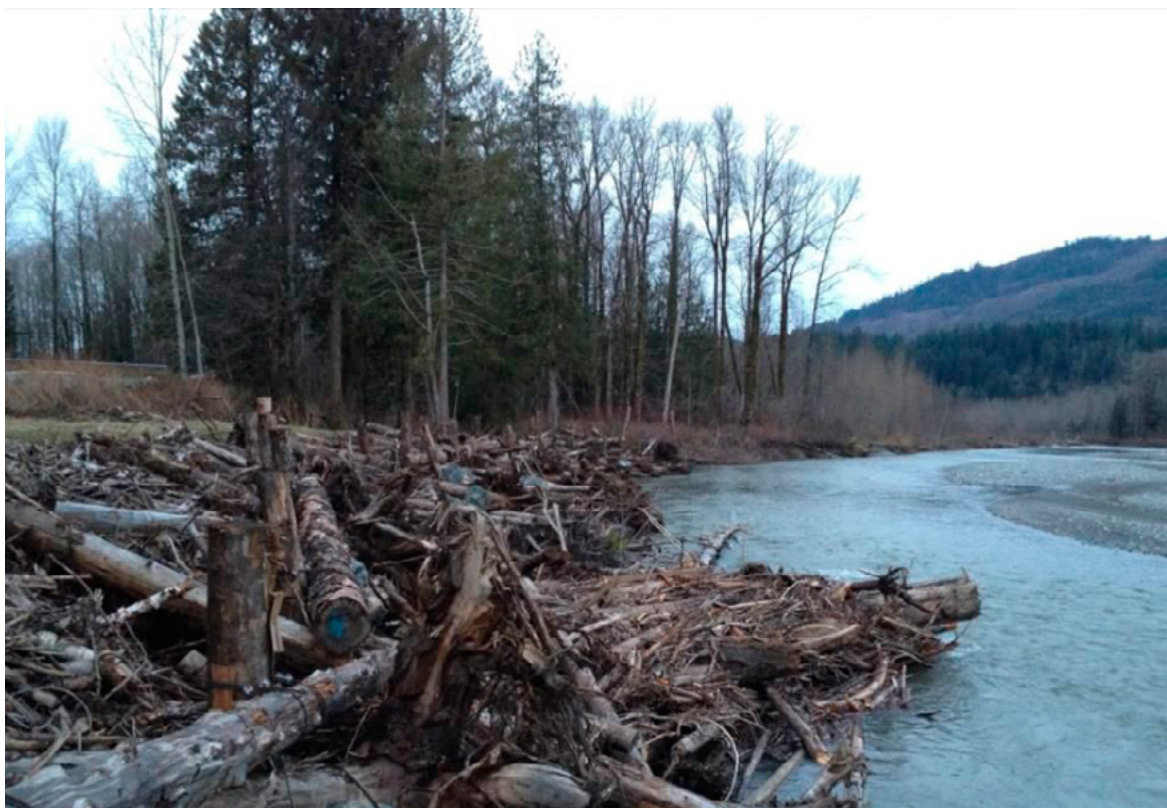
Ryc. 19. Umocnienie brzegu z użyciem grubego rumoszu drzewnego (źródło: Bureau of Reclamation and U.S. Army Corps of Engineers (2015); fot.: Tim Abbe)
